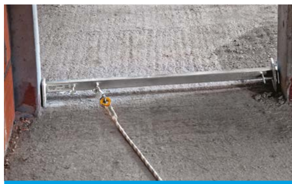
Kotwienie do belki poprzecznej mocowanej w otworach ściennych.
