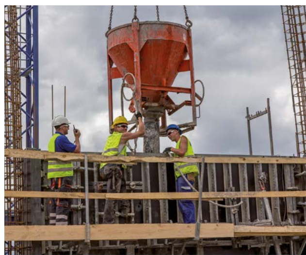
Podesty zabezpieczone balustradą. Pracownik obsługujący urządzenie do zagęszczania betonu powinien pracować w rękawicach antywibracyjnych.
