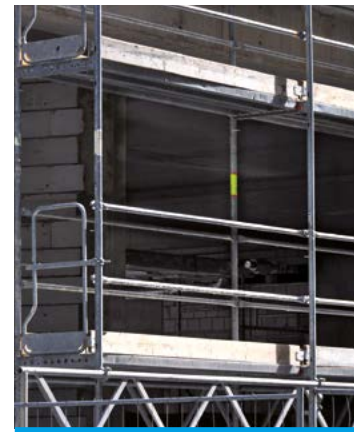
Balustrady ochronne od szczytu rusztowania.
