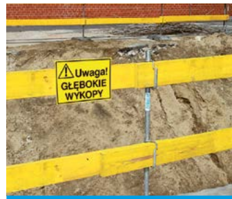
Zabezpieczenie krawędzi wykopu.
