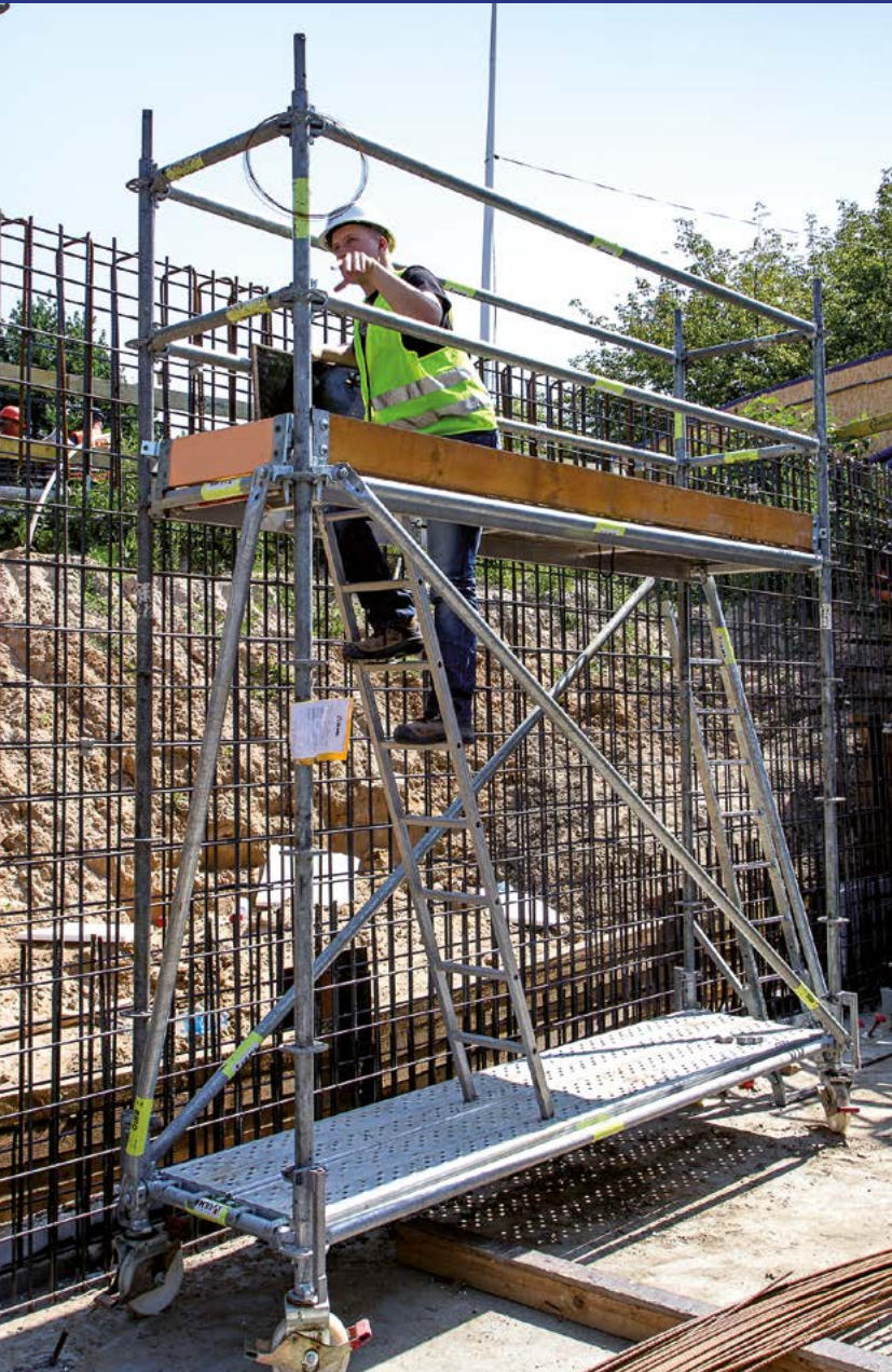
Hamulec rusztowania przejezdnego.
