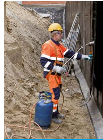
Pracownik może pracować wyłącznie w wykopie zabezpieczonym przed osunięciem gruntu.
