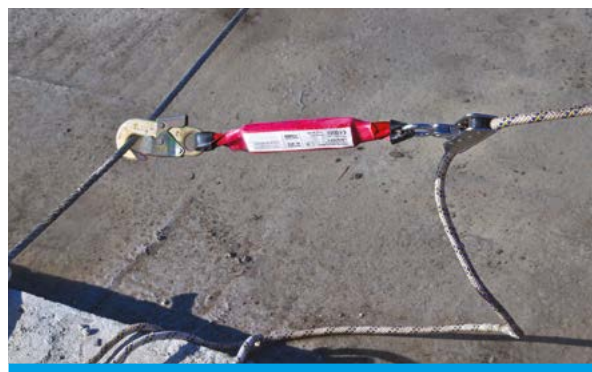
Kotwienie do prowadnicy liniowej stosowanej zgodnie z zaleceniami producenta.
