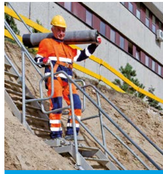
Bezpieczne zejście do wykopu.
